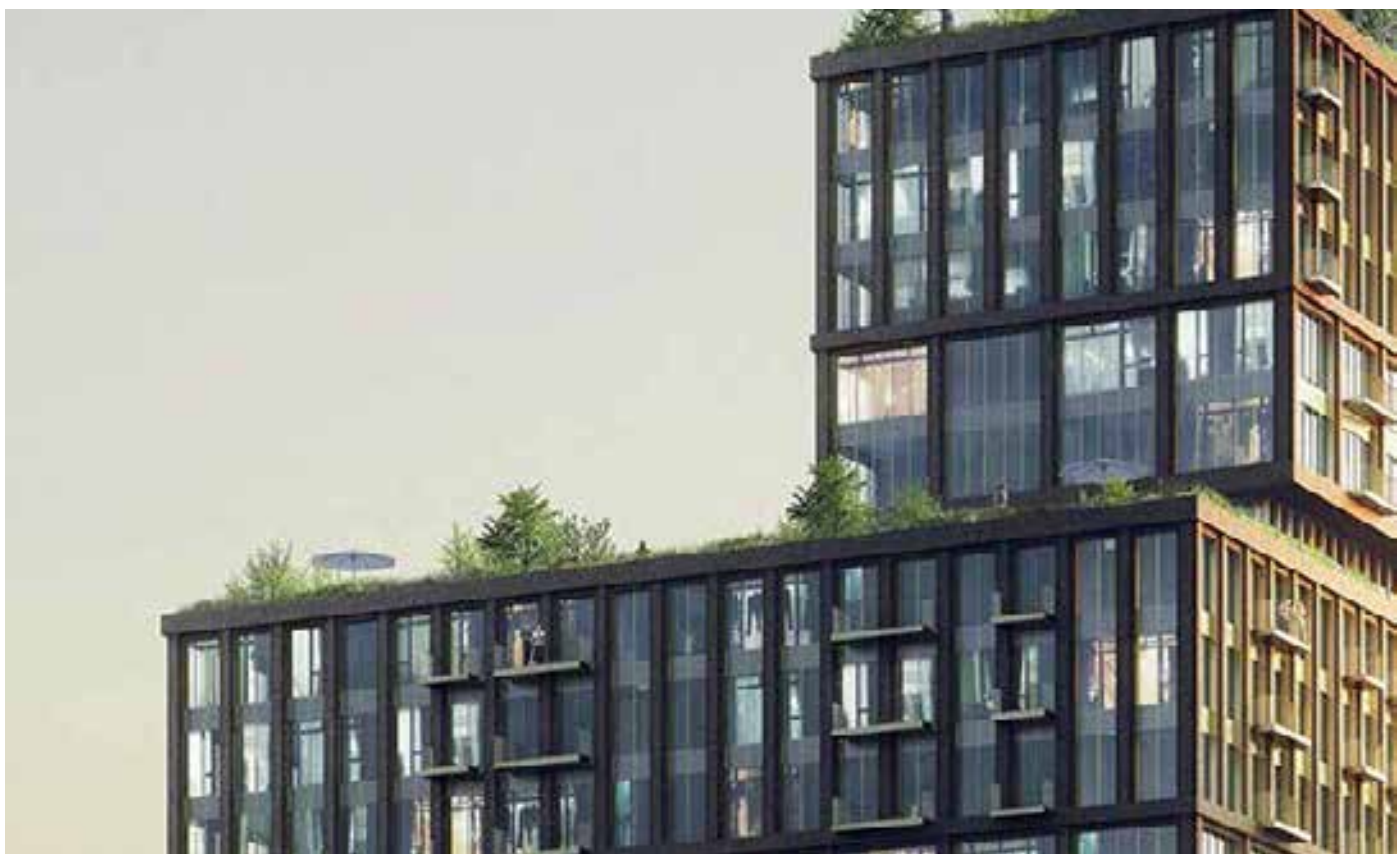
Beplanting zichtbaar op de dakranden
