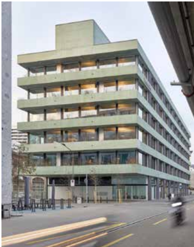
Geleding met banden en bijzondere dakvorm
