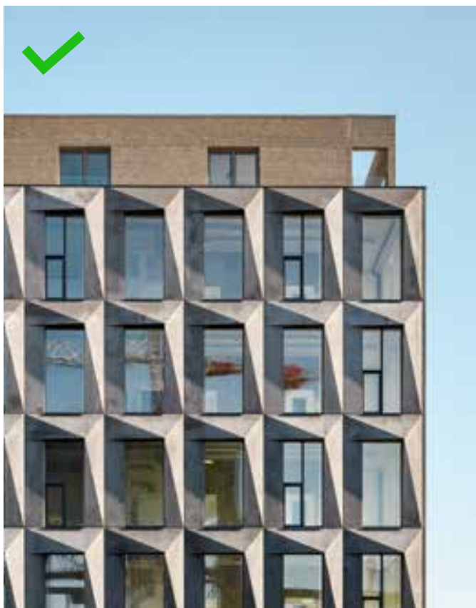
Geen installaties zichtbaar
