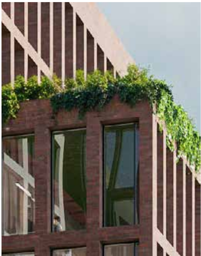
Beplanting op de dakranden
