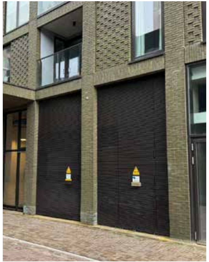
Trafo's binnen het stramien van de gevel
