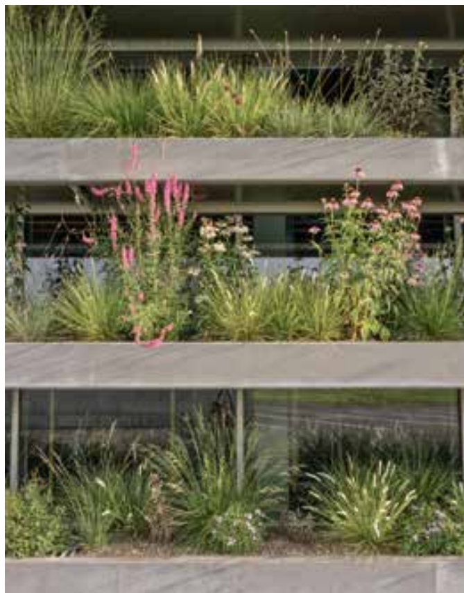
Verwerkt in de gevel
